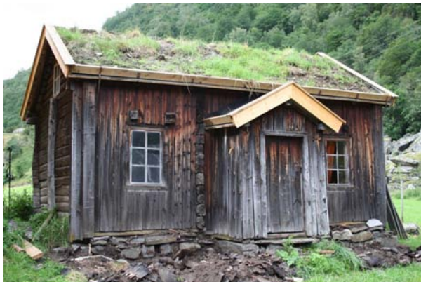
Rehabiliter bustadhus på Spangelo
