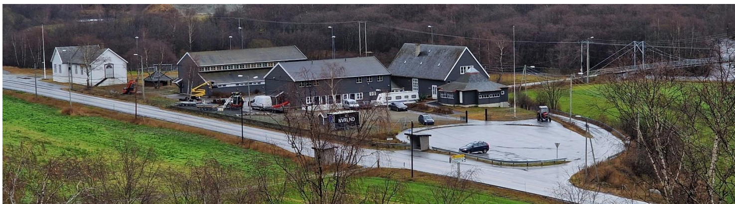
Figur 32: Ved gamle Ljøsne skule er det planlagt ny ladestasjon
