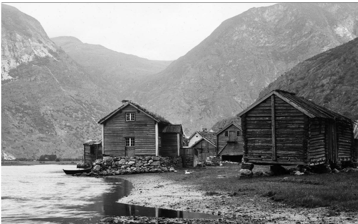
Figur 29. Dei aller fleste bygningane ved fjorden var opprinneleg naust og buer. Etter kvart vart mange naust påbygde, utvida og omgjorde til bustadhus. Foto: Mittet & Co./Nasjonaltbiblioteket, ca. 1900.
