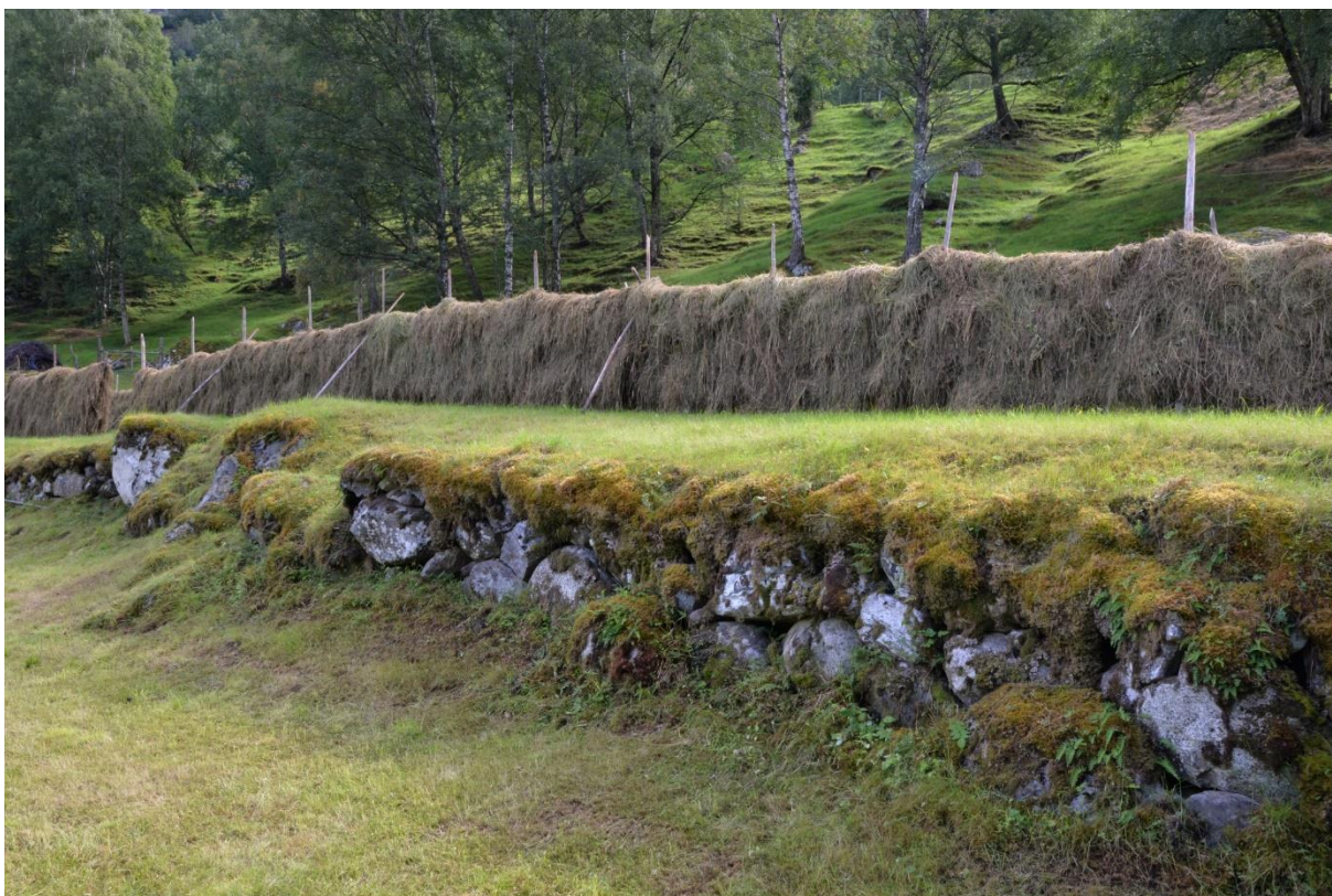
Figur 41. Bakkemur som støttar opp og flatar ut skråningar.
