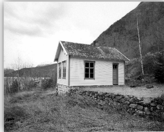
Bilete: Skulehuset i Vindedalen
