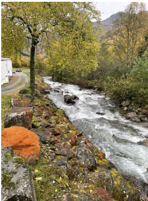
Figur 5-25: God sikring mot bebyggelse i øvre del, men varierende høyde og kvalitet lengre nedstrøms.
