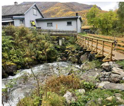
Figur 5-28: Bedre sikring på Volldølas østside.
