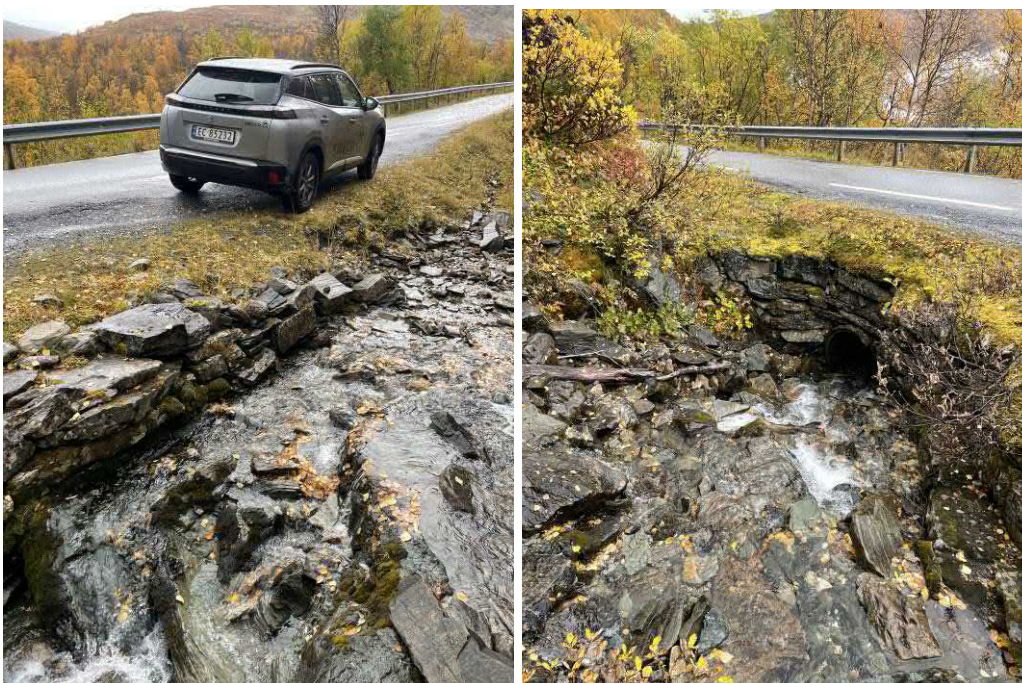
Figur 5-9: Skinnstøene: bekken går et par meter langs grøft før den svinger mot høyere inn i liten stikkrenne med begrenset kapasitet.
