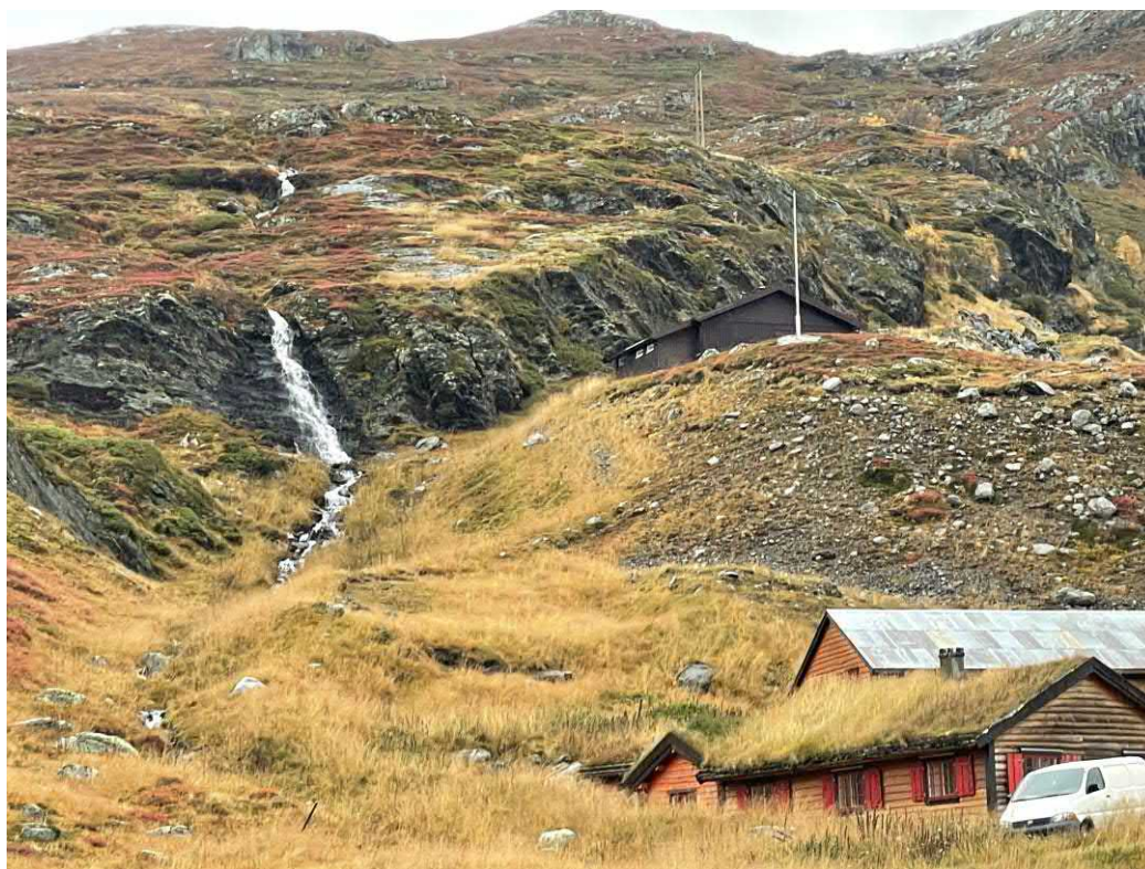
Figur 5-38: Bekk kan grave i skråningsfot mot bygning til høyre i bildet.
