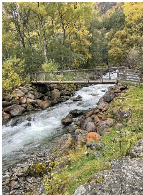
Figur 5-26: Gangbru er godt sikret og kapasiteten er antakeligvis god.
