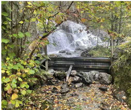
Figur 5-16: Provisorisk oppdemning ved bunn av fossefall.
