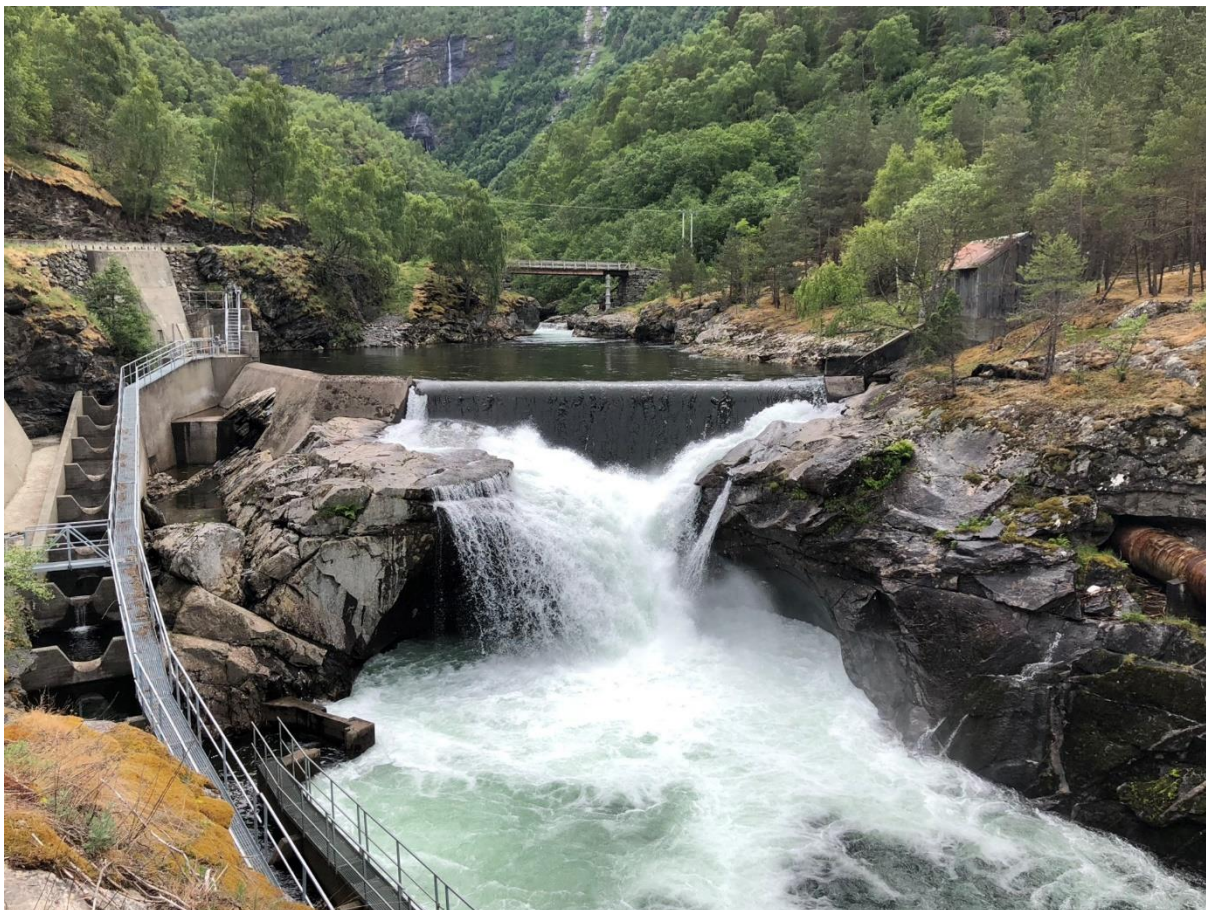
Figur 4: Fisketrapp ved Husum. Foto: Gert Høgseth, NVE.
