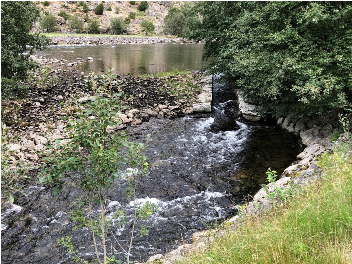
Figur 2: Vassintak til Seltakilen, Seltun. Kilen vart restaurert i samband med Statens Vegvesen si oppgradering av E16. Hovudelva renn mot venstre i bakgrunnen. Foto: Gert Høgseth, NVE.
